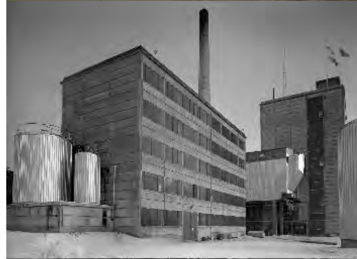
Vasemmalla alhaalla haihduttamon lisärakennus vuonna 1973. Oikealla ylhäällä haihduttamon rakennukset vuonna 1969 ja alhaalla vastavalmistuneena 1961. Mustavalkokuvat Vapriikin kuva-arkisto.
