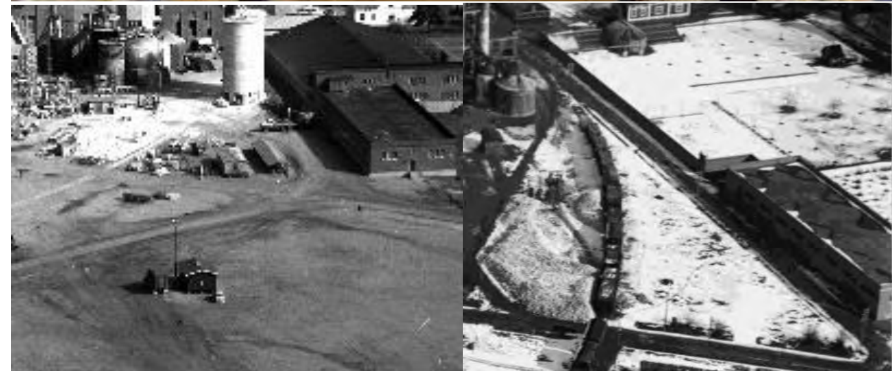
R2. Ylhäällä vasemmalla rakennus pohjoisen suunnasta. Alaosassa R1 ja R2 piirustukset. Oikean puolen kuvissa uudemman vesilaitokset sisätilat ja alla kuvat 1960-luvulta sekä 1930-luvun taitteesta, jolloin uudemman vedenpuhdistuslaitoksen paikalla vielä oli tehtaan tenniskenttä ja kartanon kasvihuone. Vanhat kuvat Vapriikin kuva-arkisto. Piirustukset: M-Realin piirustusarkisto, TKA.
