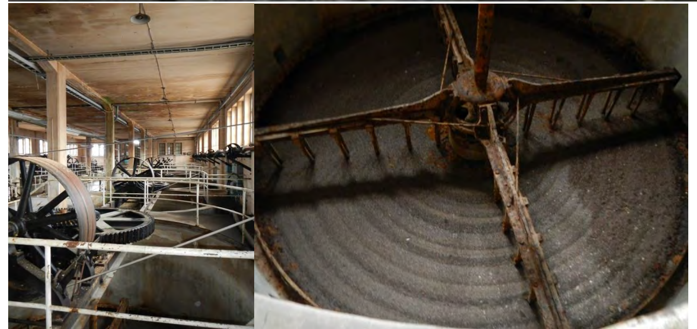
R1. Vasemmalla ylhäällä sisäänkäynti ja poikkipääty, johon on sijoitettu henkilökunnan tilat, oikealla eteläpään ovi, alakuvassa neljän ikkunan ryhmä, niiden alla alumiinisulfaatin purkauspaikka ja sen johdosta tuhoutunutta tiiliseinää. Oikeanpuoleisissa kuvissa rakennuksen keskikäytävä ja sen molemmin vedenpuhdistuslaitaita puhdistuslaitteineen.
